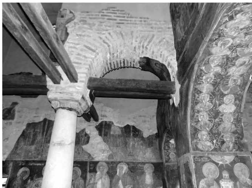
Обр. 29. Колоните от южния ред с носещата конструкция на подкуполния барабан в наоса на църквата „Св. Апостоли Петър и Павел“ във Велико Търново.
