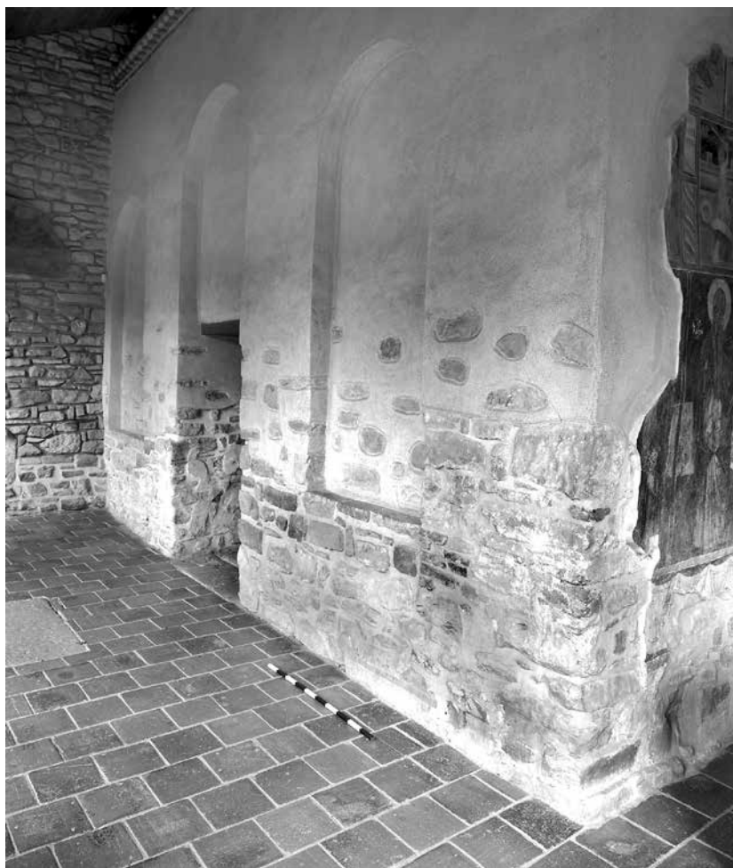
Обр. 17. Западна фасада на притвора на църквата „Св. Апостоли Петър и Павел“ във Велико Търново – поглед от юг.
