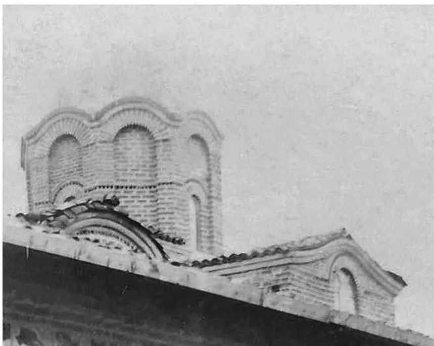
Обр. 11. Църквата „Св. Апостоли Петър и Павел“ във Велико Търново след 1908–1910 г., с детайл на подкуполния барабан и напречния кораб с глазирани глинени панички от керамопластична украса (лична колекция на И. Панайотов).
